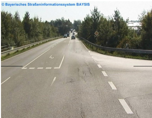
Abbildung 1: St 2080 Beginn der Baustrecke (Abschnitt 220, Station 0,120; IN-Station)
