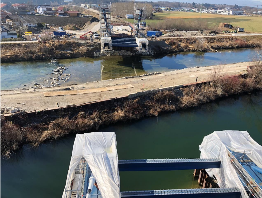
Luftbild vom März 2021: Freivorbau der Mangfallbrücke (Copyright: Staatliches Bauamt)
