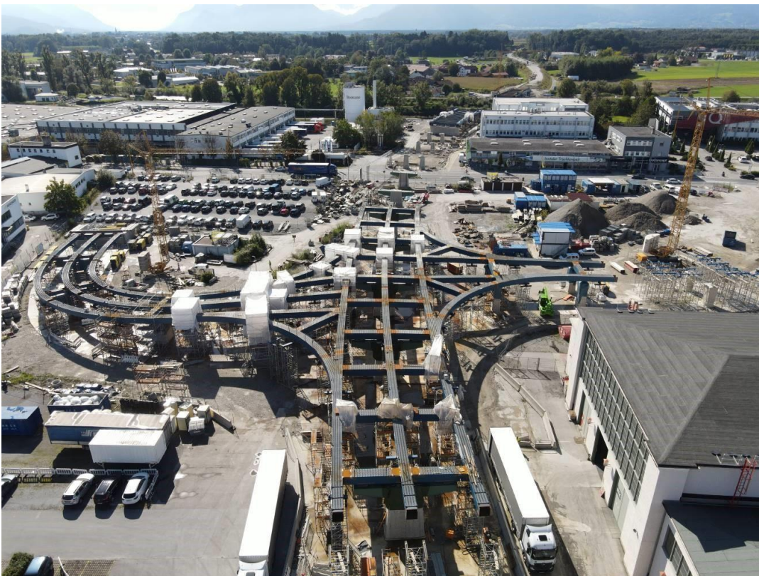
Luftbild vom Herbst 2020: Stahlbau an der AS Aicherpark (Copyright: Habau)
