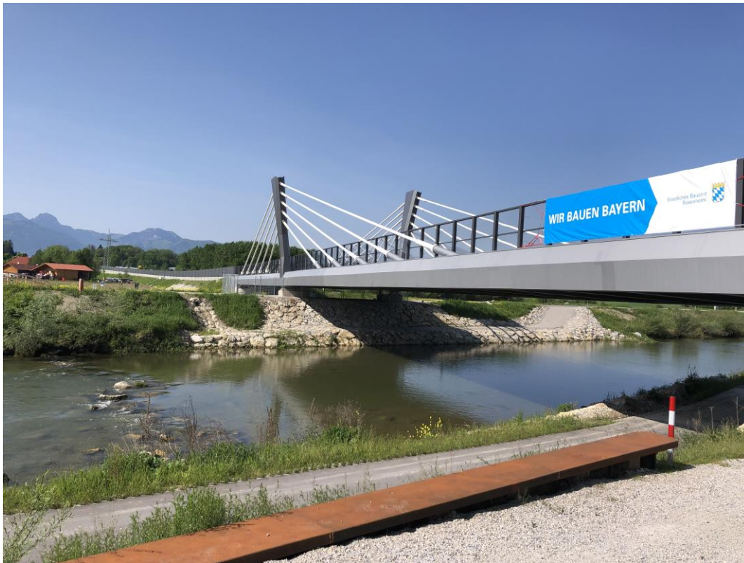
Aufnahme vom Mai 2023: Aicherparkbrücke im Bau (Copyright: Staatliches Bauamt)
